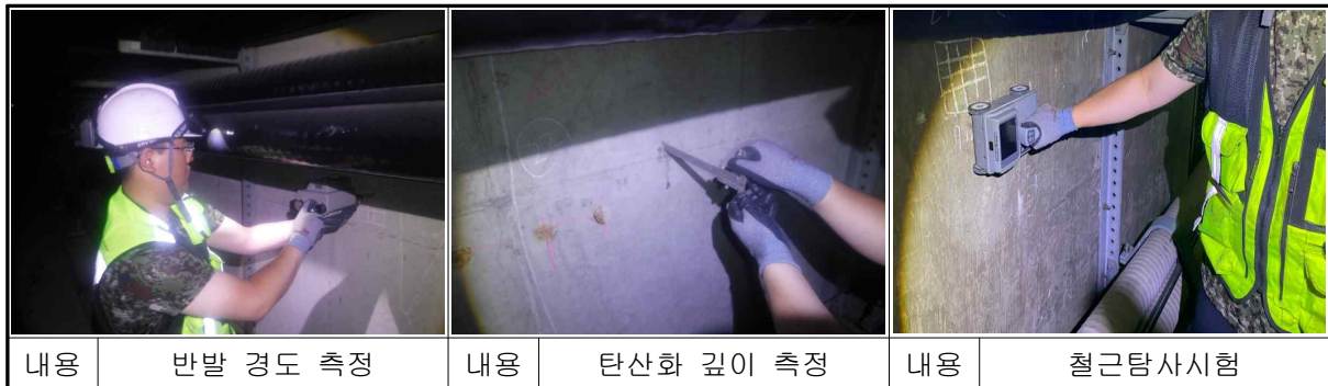
【사진 1.3】 구리인출 전력구 재료시험 전경
